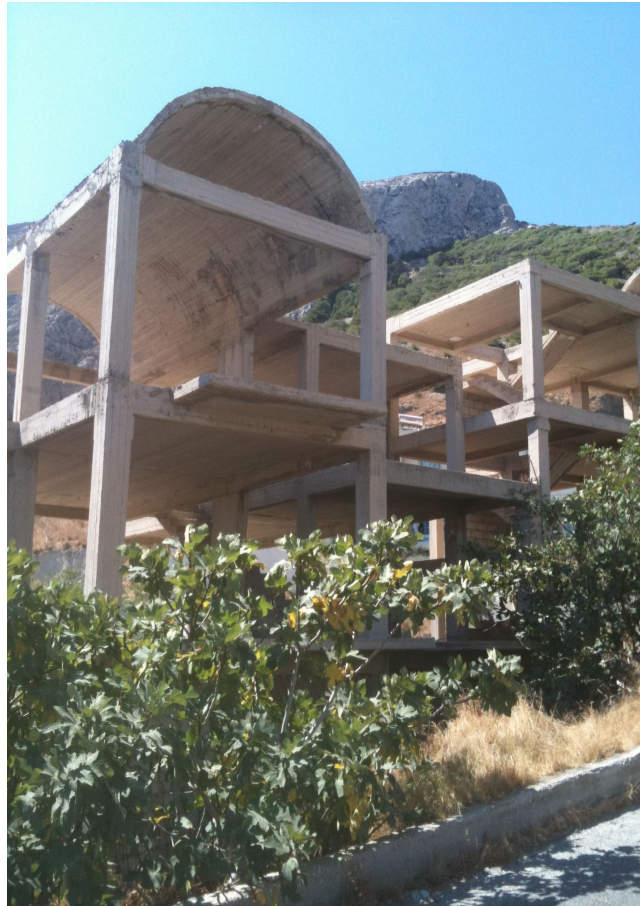
Abb. 15: Santorini, Perissa 2011 Betonbauten
